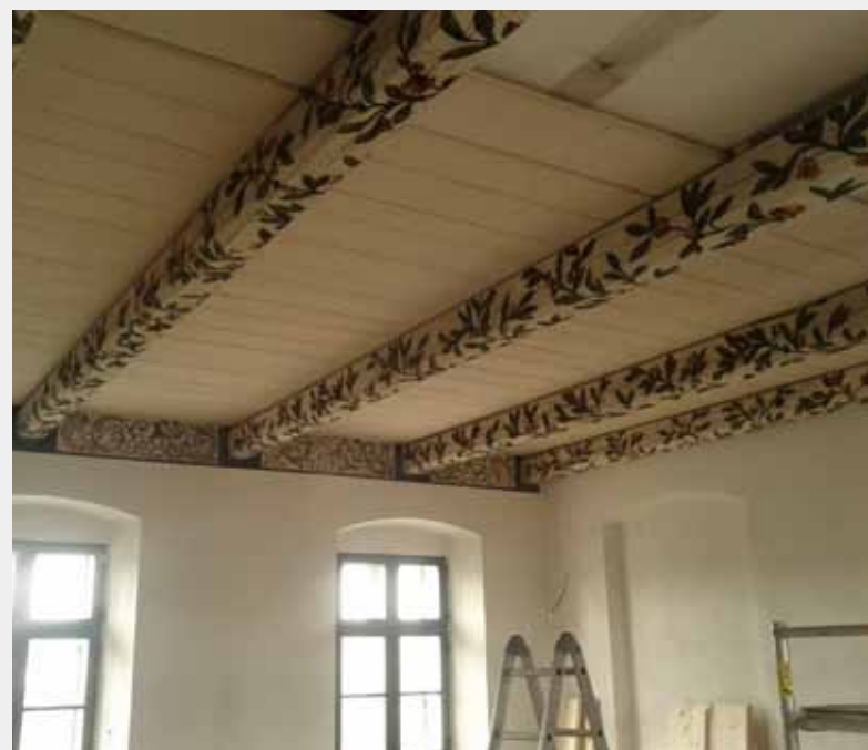
▼ Obr. 12. Rekonstrukce trémového podhledu v patře – stav září 2012
