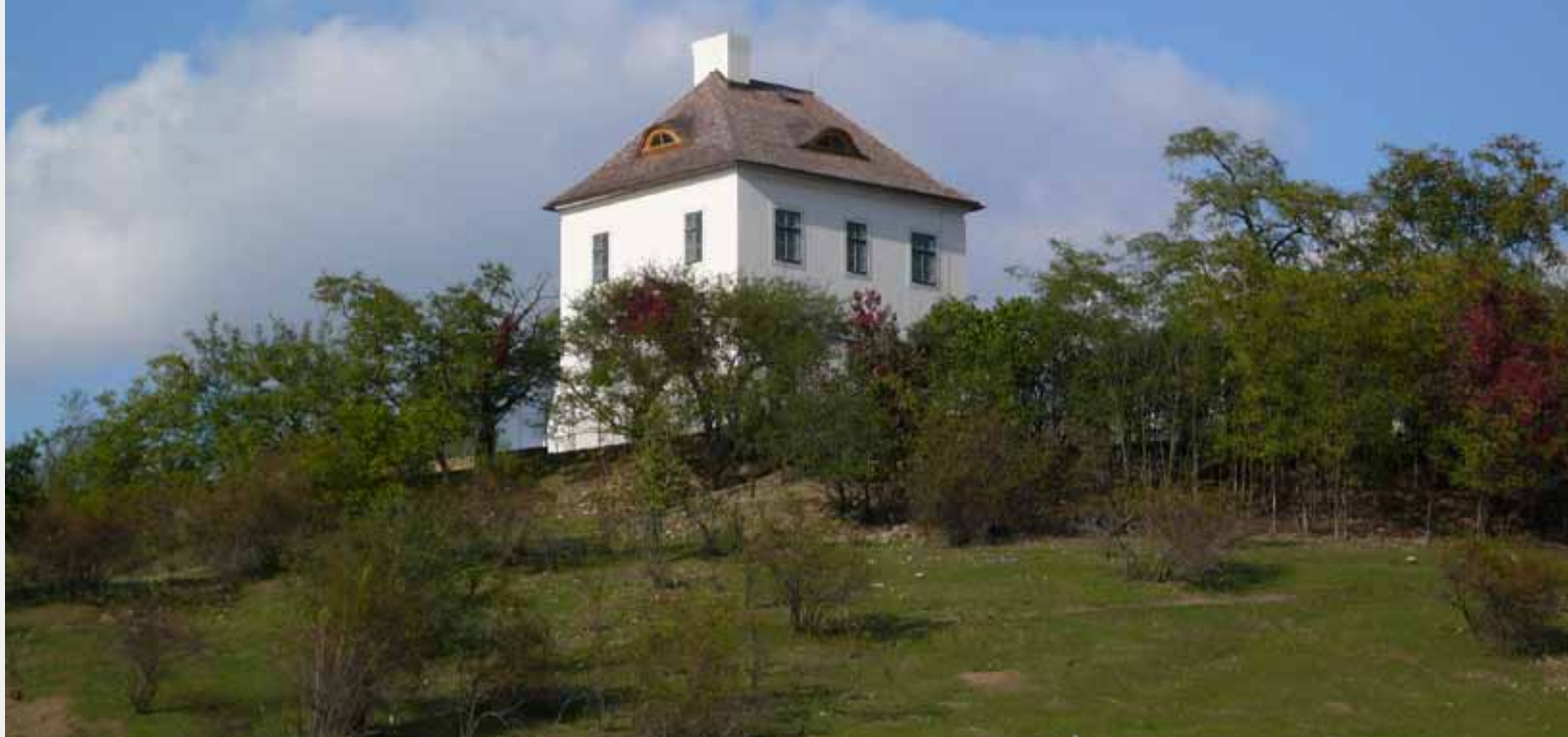
▲ Obr. 13. Pohled na stavbu Sklenářka po stavebních úpravách – stav květen 2013
