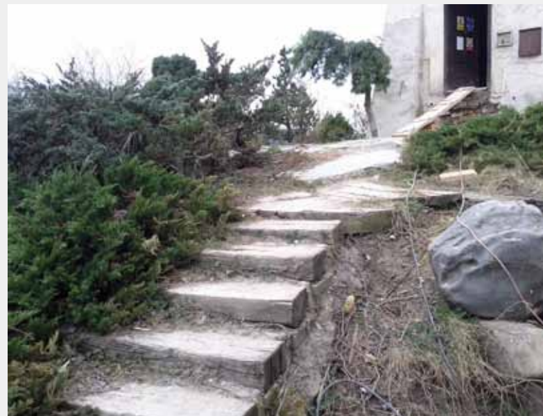
▲ Obr. 10. Vstup – stav březen 2012
