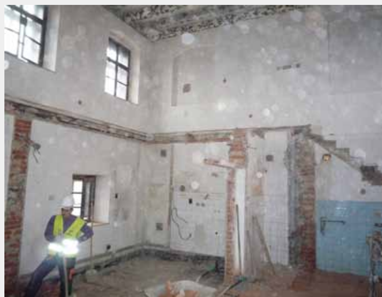
▲ Obr. 6. Stavební úpravy – stav březen 2011
