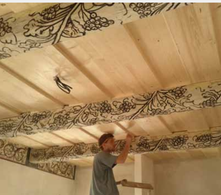
▼ Obr. 11. Rekonstrukce trémového podhledu v přízemí – stav září 2012
