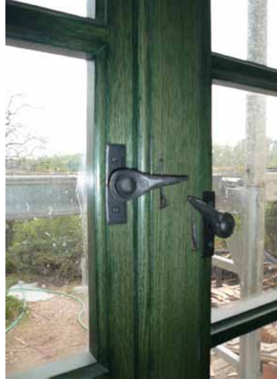
▲ Obr. 8. Nové kování oken – stav březen 2012
