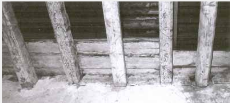
▼ Obr. 3. Trámový strop – stav před stavebními úpravami v roce 1989–1990
