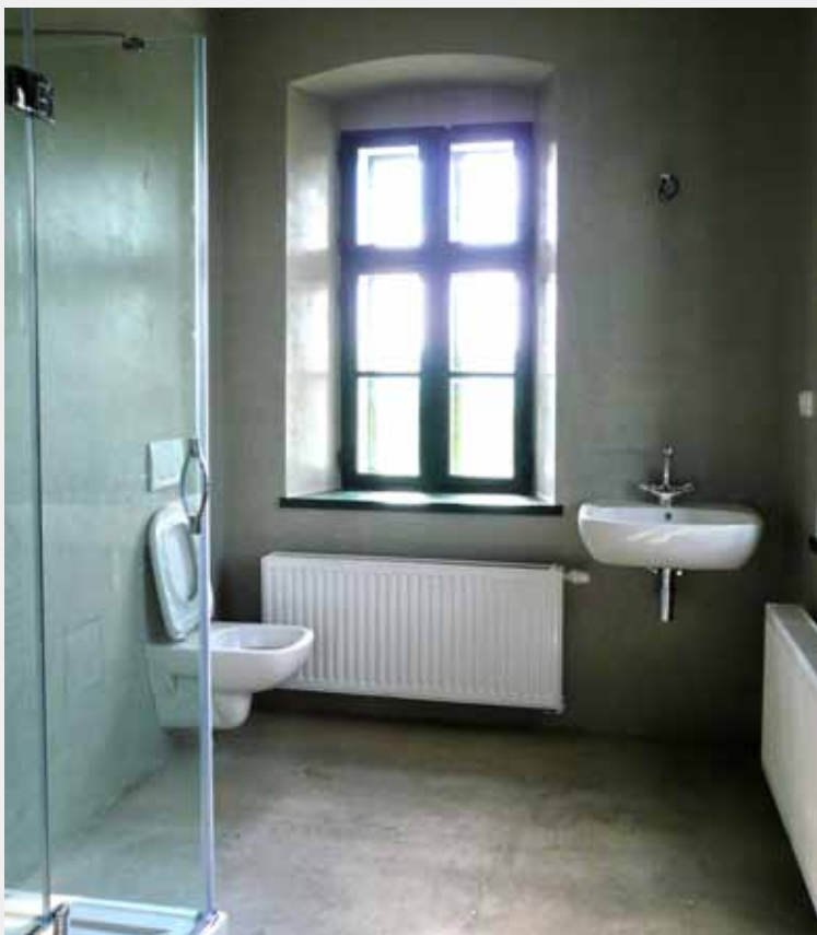
▼ Obr. 14. Koupelna v patře po obnově – stav září 2012
