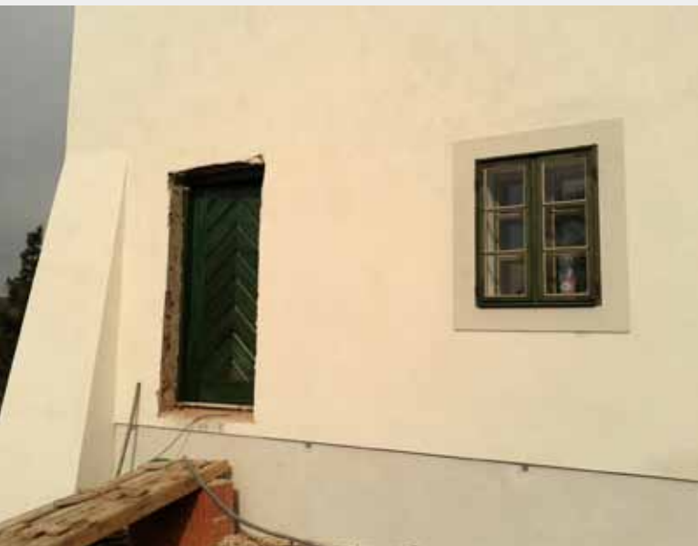
▲ Obr. 9. Nové vstupní dveře a okno – stav srpen 2012
