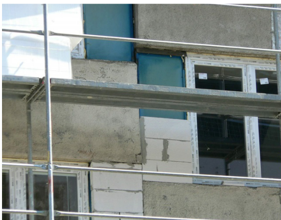
Vnější přízdívka k původnímu vnitřnímu plášti MIV.
