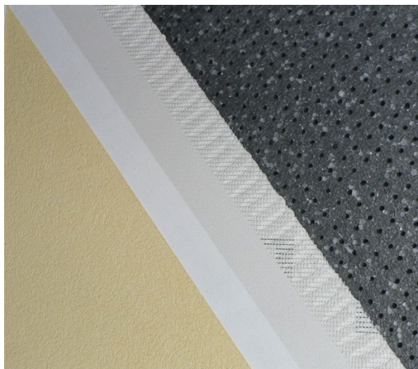
Zateplení polystyrenem s malým difúzním odporem.
