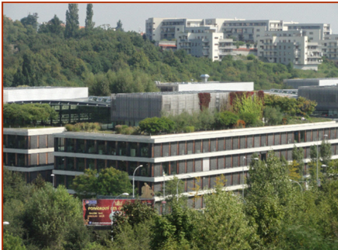
F Fig. 28 An intensive green roof, vegetation shading and other energy saving measures on the ČSOB Bank headquarters in Radlická Street (Source: http://www.csob.cz/cz/Csob/O-CSOB/Budova-CSOB-Radlice/Stranky/default.aspx .)
