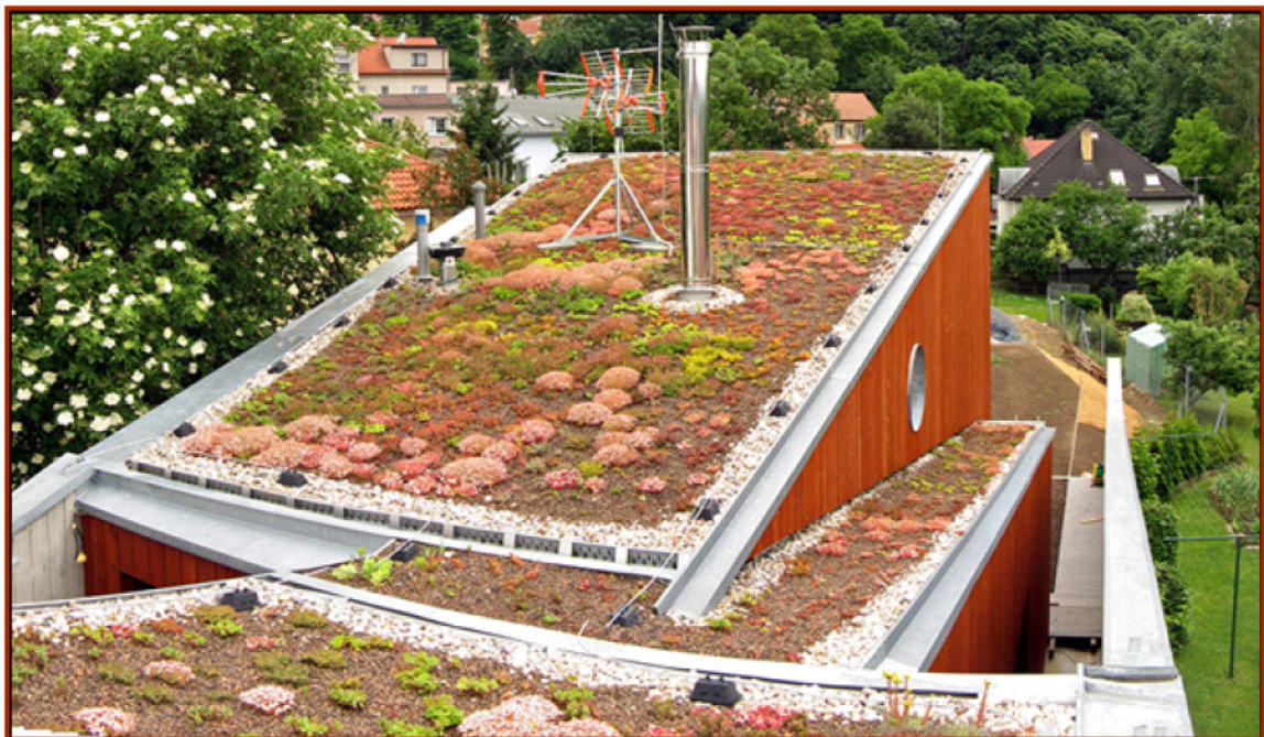
Fig. 30: An extensive green roof, Dům v úžině/House in Gorge, Praha - Jinonice (© Pavel Dostál, 2015.)
