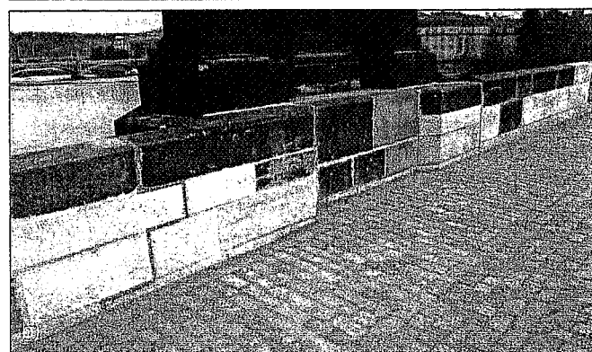
Obr. 2 a, b: Rozebíráním kamenných kvádrů se teprve zjistilo, jak špatný je stav výplně podstavců soch – pilíř č. 7 – podstavec sousoší sv. Norberta, Václava a Zikmunda. Návaznost starších i nových kvádrů na kvádry podstavců musely být řešeny bez ohledu na původní kamenofez. Svislá spára vzadu (obr. a) i klikatá spára vlevo vpředu, (obr. b) byly vyplněny tvárnou hmotou s funkcí dilatace.
