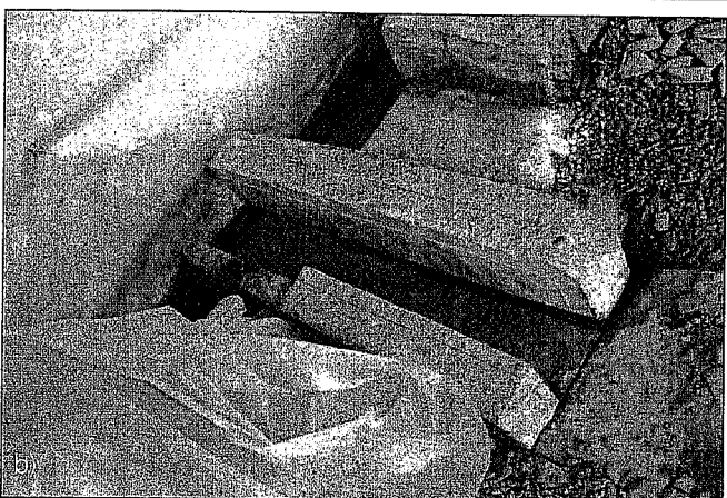
Obr. 12 a, b: Úspěšná kamenická oprava jižního chrliču na X klenbovém poli. Poškozený chrlič z žehrovické arkozy v původní poloze byl opraven z vhodných částí jednoho z vyřazených bloků stejného petrografického složení.
