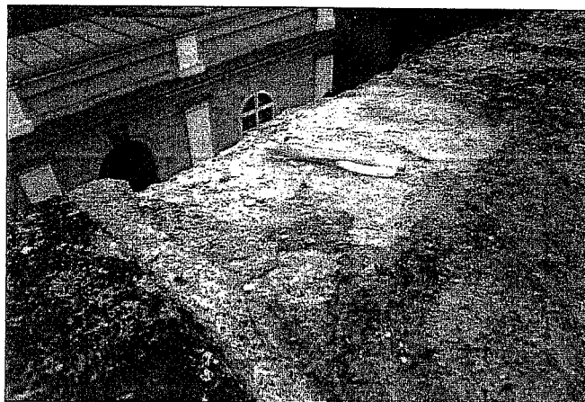
Obr. 13 U zpětně osazeného horního tvarovaného kvádrů zábradlí v poli XII, kámen č. 14, ze žehrovické arkozy se po roce osazení odlomila asi 2 cm mocná a cca 3 kg těžká povrchová část kvádrů, což kritiky bylo označeno za hrubé pochybení kameníků. Zde však neselhali kameníci, avšak ti, co připustili zpětné osazení poškozeného kvádrů, u kterého přehlédli skrytou vadu. Nicméně kvádrů byl kameníky opraven s pomocí nové výplně tak, že bývalou poruchu ani odborník neobjeví.
