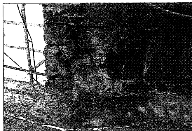
Obr. 4 Výplň podstavce pod sousoším sv. Františka Borgiáše na pilíři č. 7 – jih Fig. 4 The pedestal filling material of the St. Francis Borgias statuery-pier No. 7 – south
