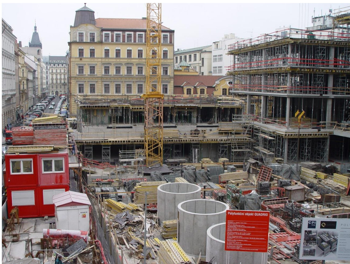
Obr. 28: Stavba polyfunkčního objektu QUADRIO (prosinec 2013)
