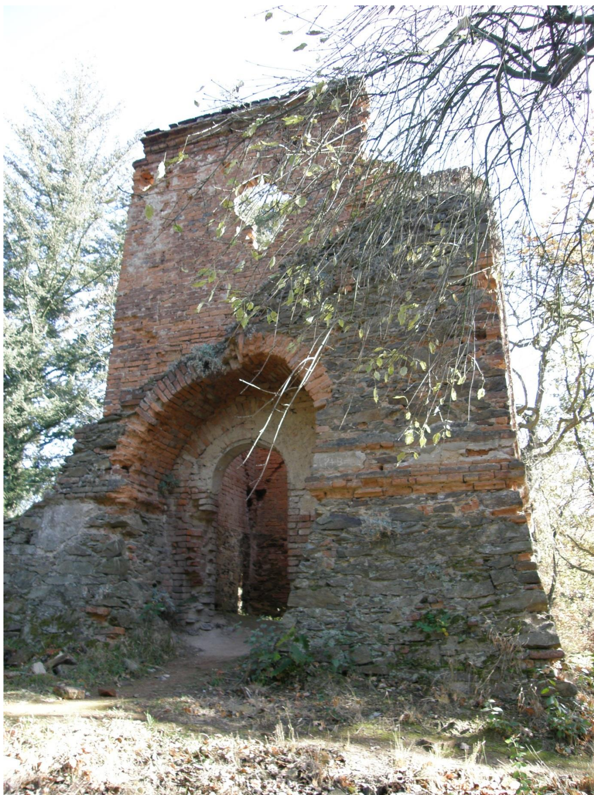
Obr. 50: Pohled na Gloriet ze severozápadu – stav před obnovou
