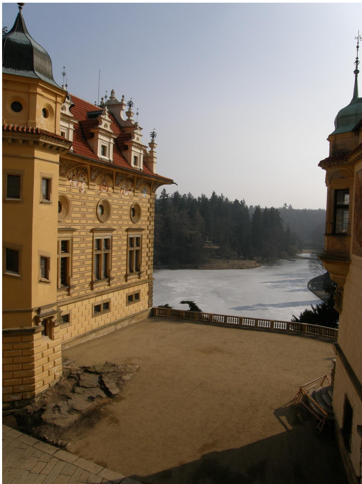
Obr. 60: Zámecká vyhlídková terasa – stav po obnově
