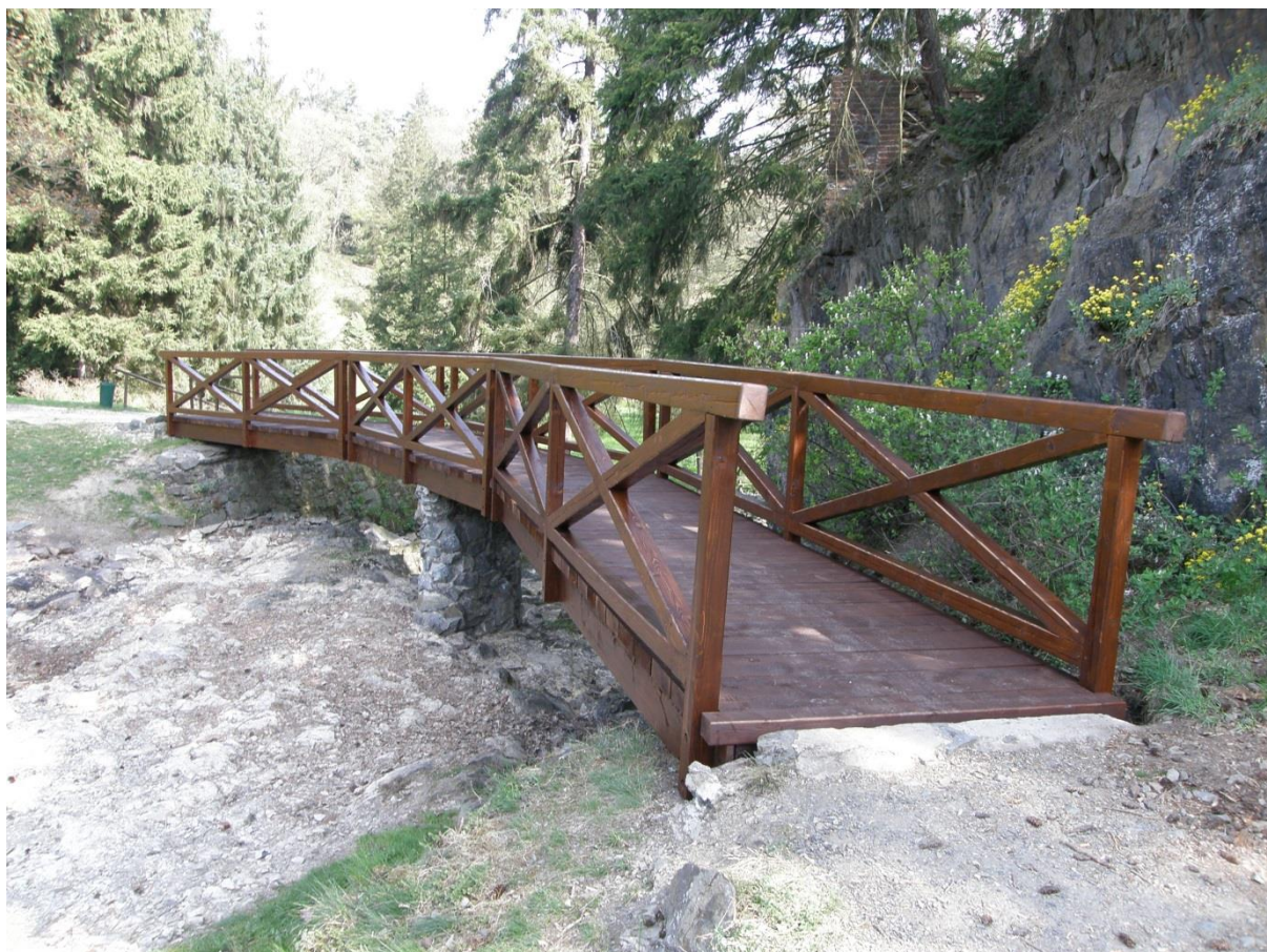
Obr. 63: Rekonstrukce dřevěných mostků přes bezpečnostní přeliv rybníka Bořín – stav po rekonstrukci
