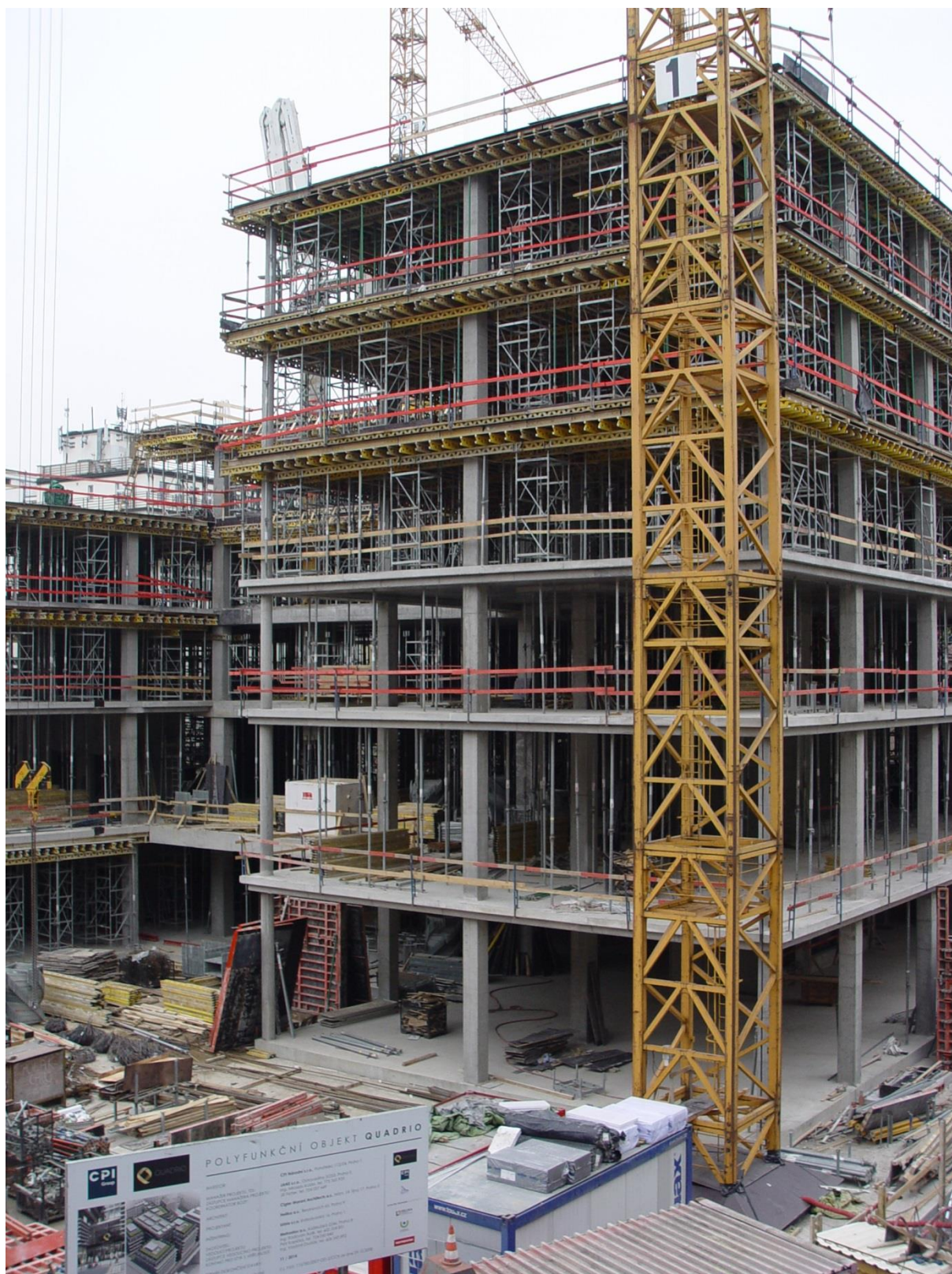
Obr. 29: Stavba polyfunkčního objektu QUADRIO (prosinec 2013)
