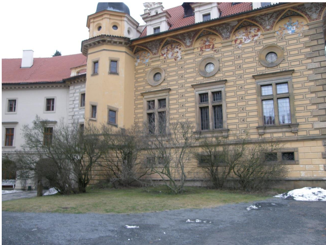
Obr. 58: Zámecká vyhlídková terasa – stav před obnovou
