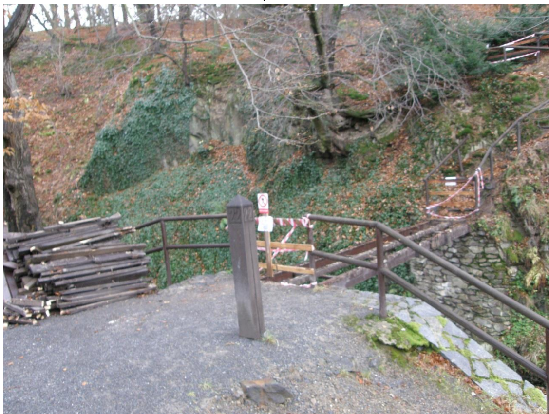
Obr. 62: Rekonstrukce dřevěných mostků přes bezpečnostní přeliv rybníka Labeška - během prací
