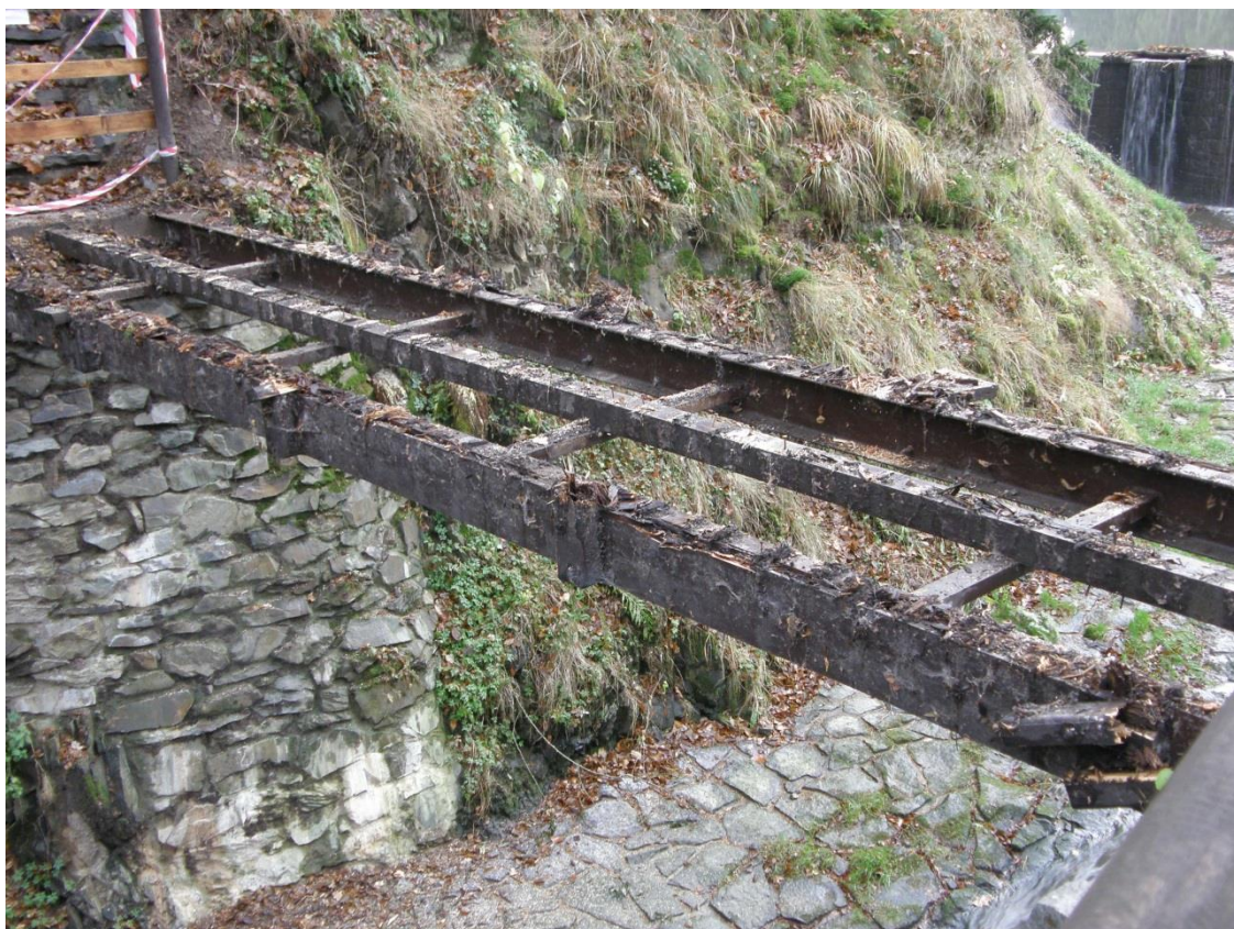
Obr. 61: Rekonstrukce dřevěných mostků přes bezpečnostní přeliv rybníka Labeška - během prací
