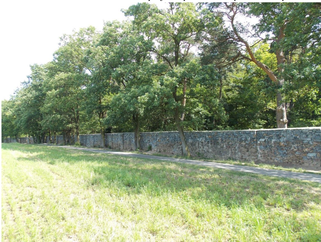
Obr. 53: Historická kamenná ohradní zeď při jihozápadní hranici parku – stav po obnově
