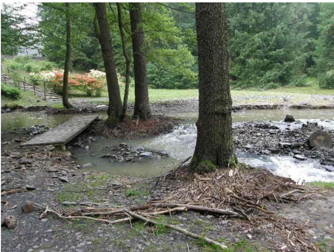
Obr. 89: Partie pod bezpečnostním rybníkem Bořín – stav po povodni v červnu 2013
