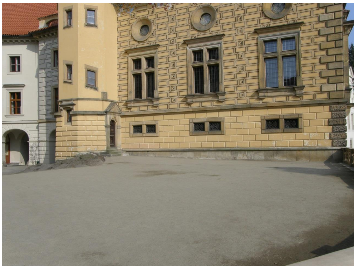
Obr. 59: Zámecká vyhlídková terasa – stav po obnově
