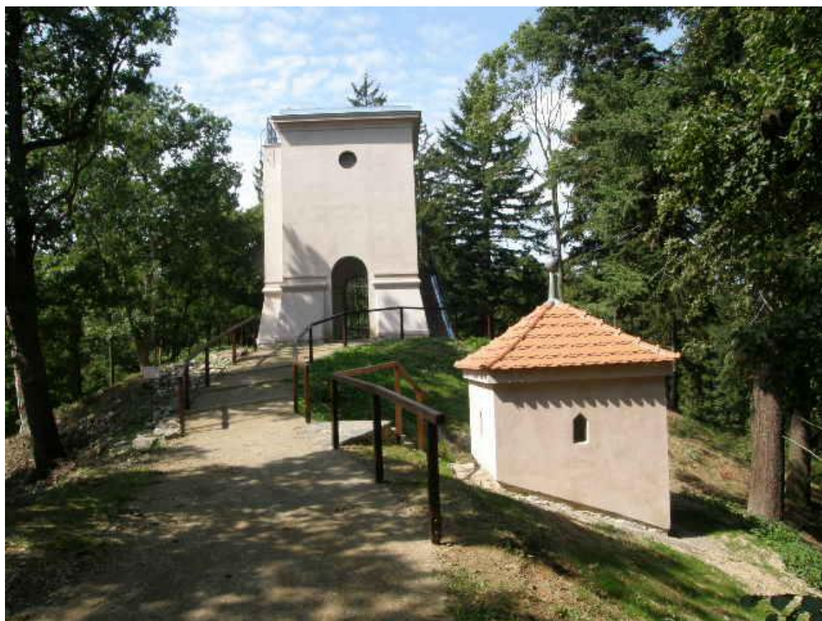
Obr. 49: Pohled na Gloriet z jihovýchodu – stav po obnově
