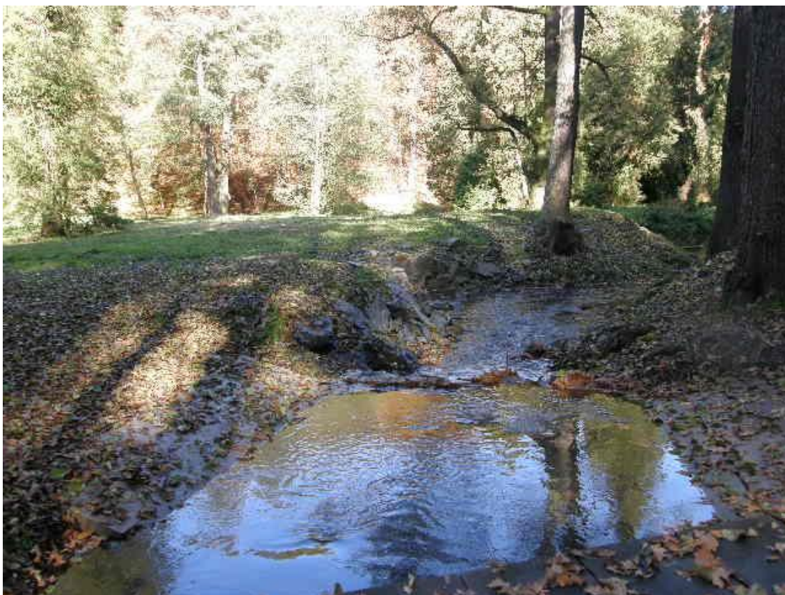
Obr. 92: Partie pod bezpečnostním rybníkem Bořín – stav po obnově
