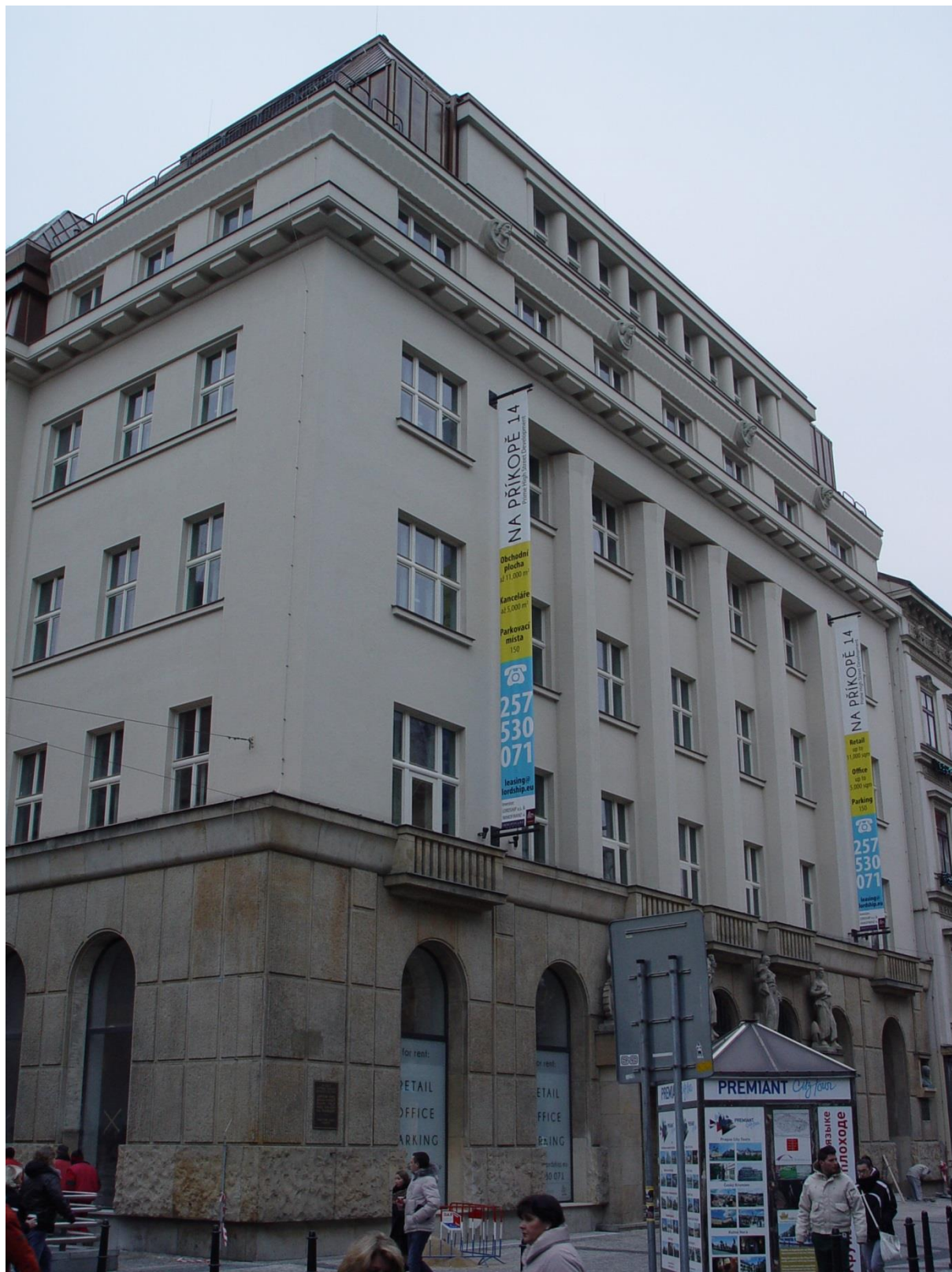
Obr. 33: Objekt Na Příkopě 854/14 – Panská (prosinec 2013)
