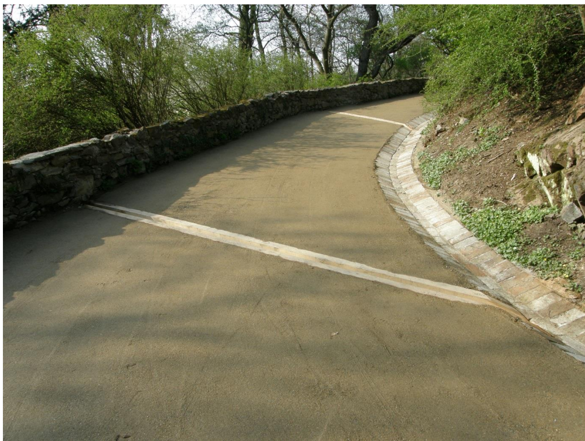
Obr. 56: Obnova severozápadní přístupové cesty od zámku do parku – stav po obnově
