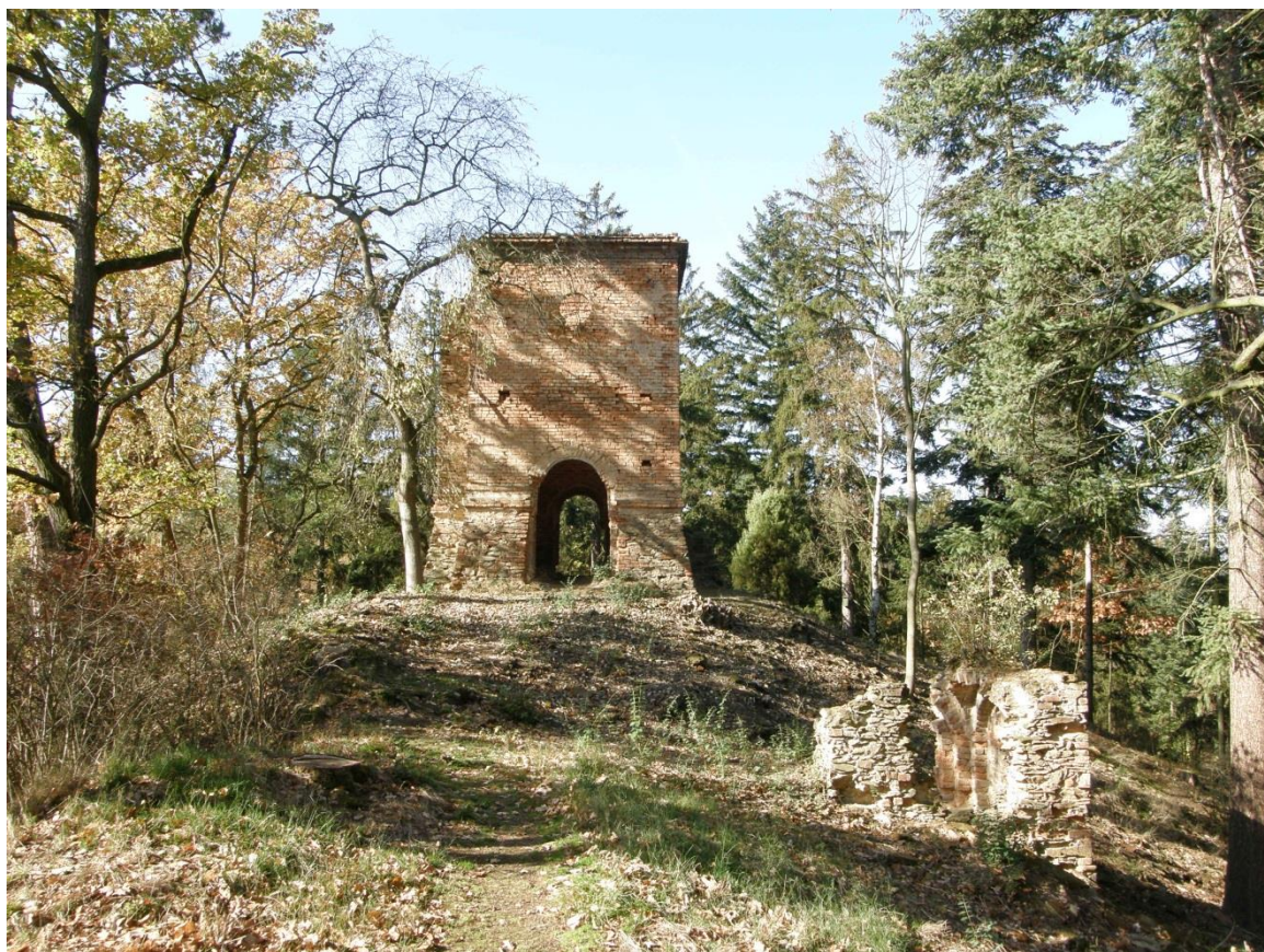
Obr. 48: Pohled na Gloriet z jihovýchodu – stav před obnovou
