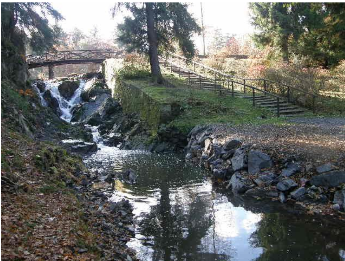
Obr. 88: Partie pod bezpečnostním rybníkem Bořín – stav po obnově
