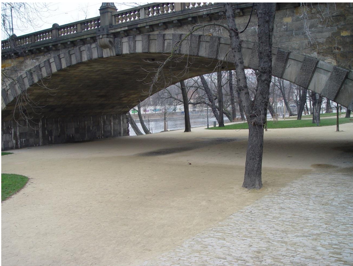
Obr. 23: Střelecký ostrov po revitalizaci (prosinec 2013)
