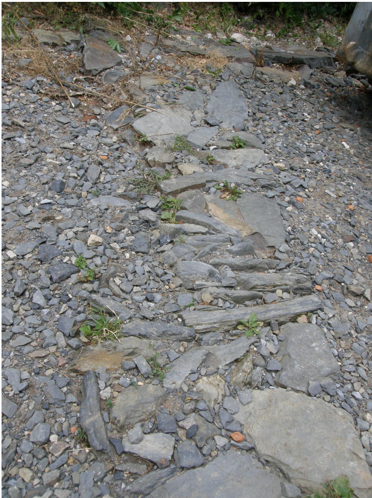
Obr. 54: Obnova severozápadní přístupové cesty od zámku do parku – stav před obnovou
