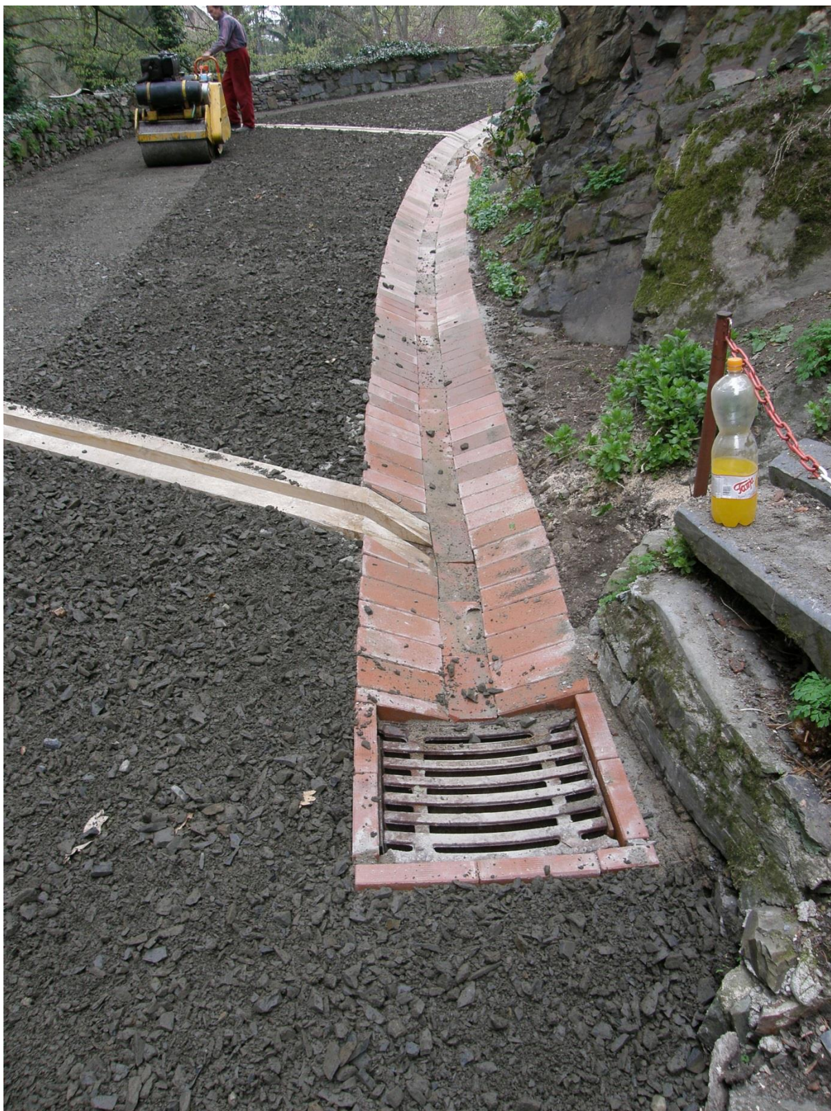
Obr. 55: Obnova severozápadní přístupové cesty od zámku do parku – průběh prací
