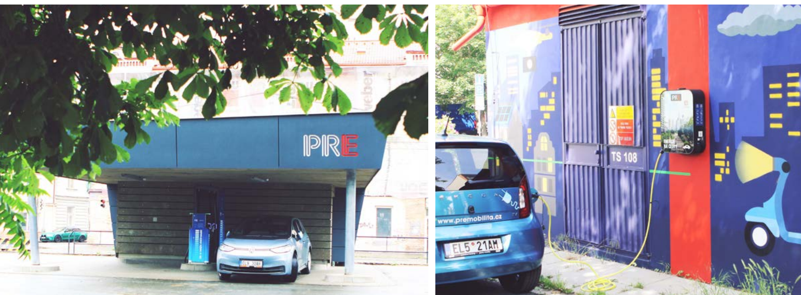
Dodavatel elektřiny PRE se aktivně podílí na budování pražské dobíjecí infrastruktury, která částečně využívá síť trafostanic. FOTO: PRE, A.S.
