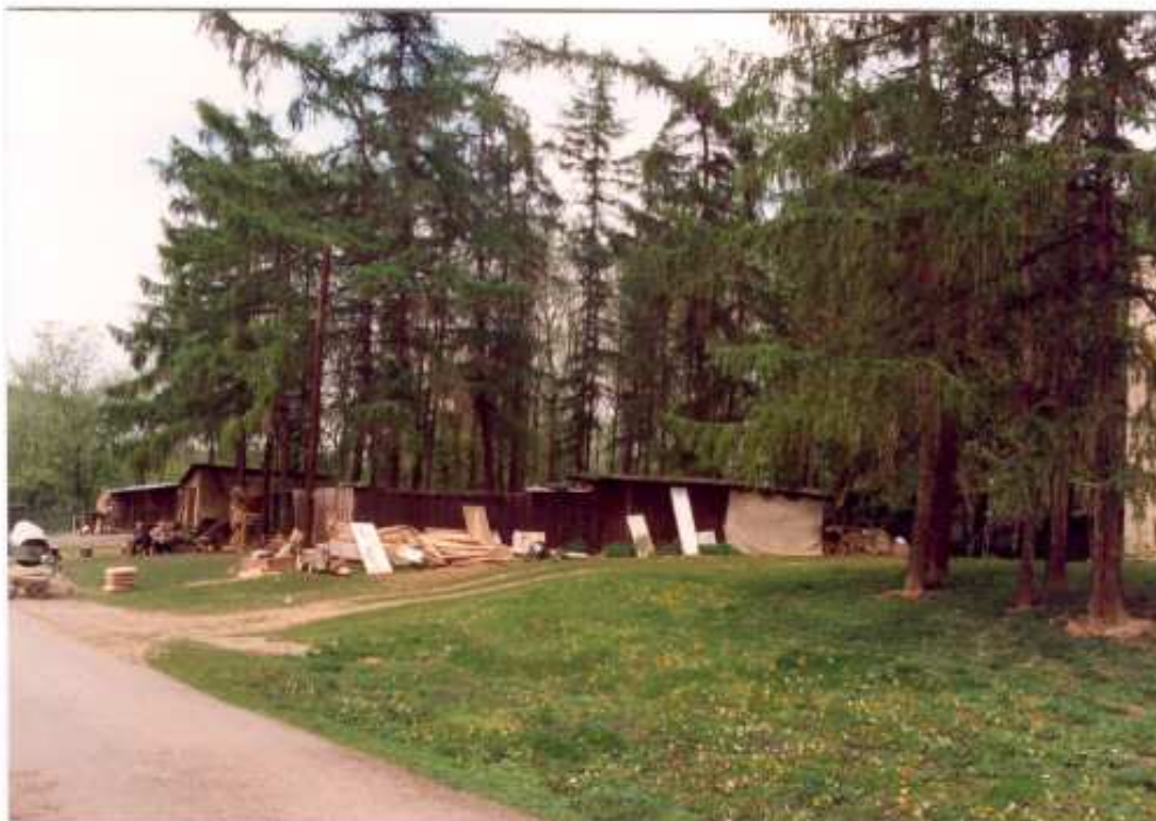
Pohled na okraj porostu 2E1 u obytné zástavby: nepovolené kolny, garáže, udírna, skládky materiálu a odpadů
