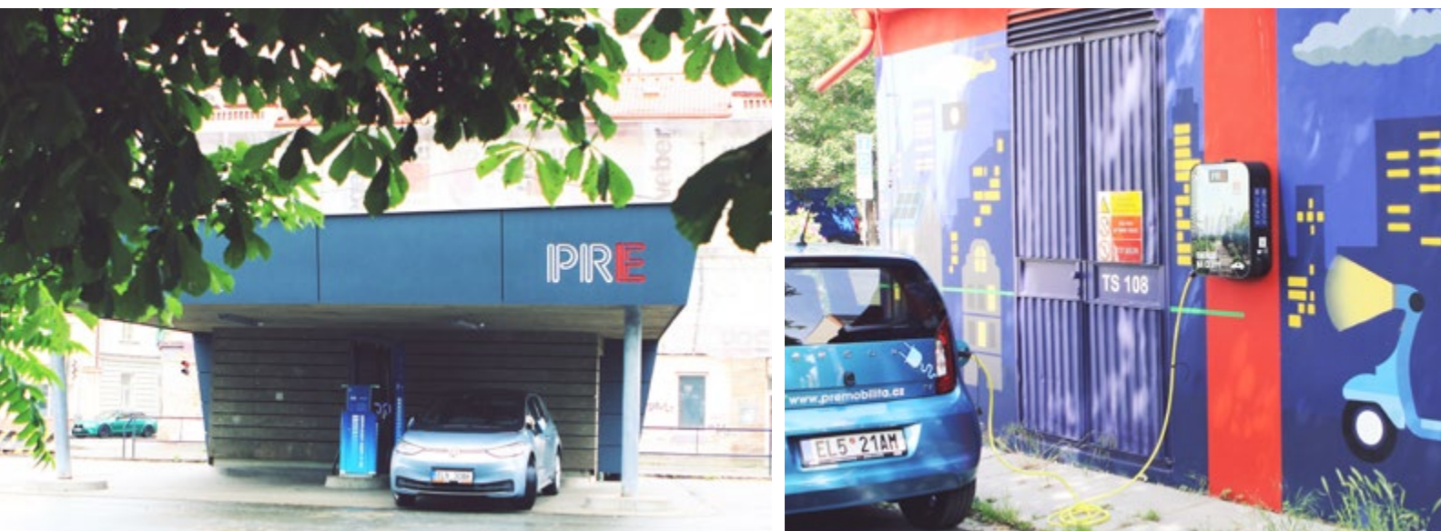
Dodavatel elektřiny PRE se aktivně podílí na budování pražské dobíjecí infrastruktury, která částečně využívá síť trafostanic. FOTO: PRE, A.S.
