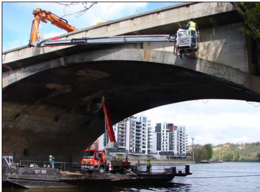
Obr. 6: Provádění diagnostiky mostu
