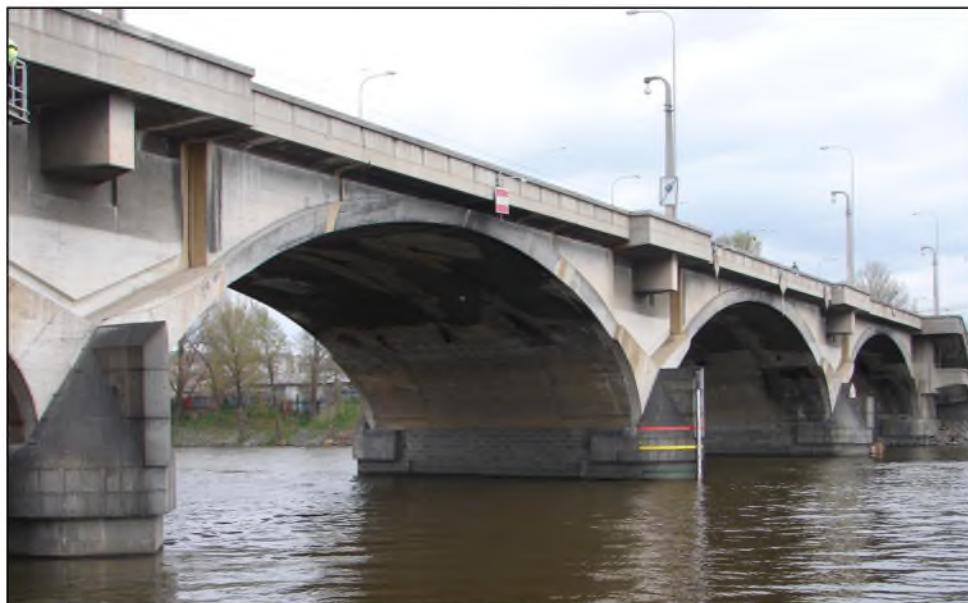
Obr. 3: Klenbová část mostu
