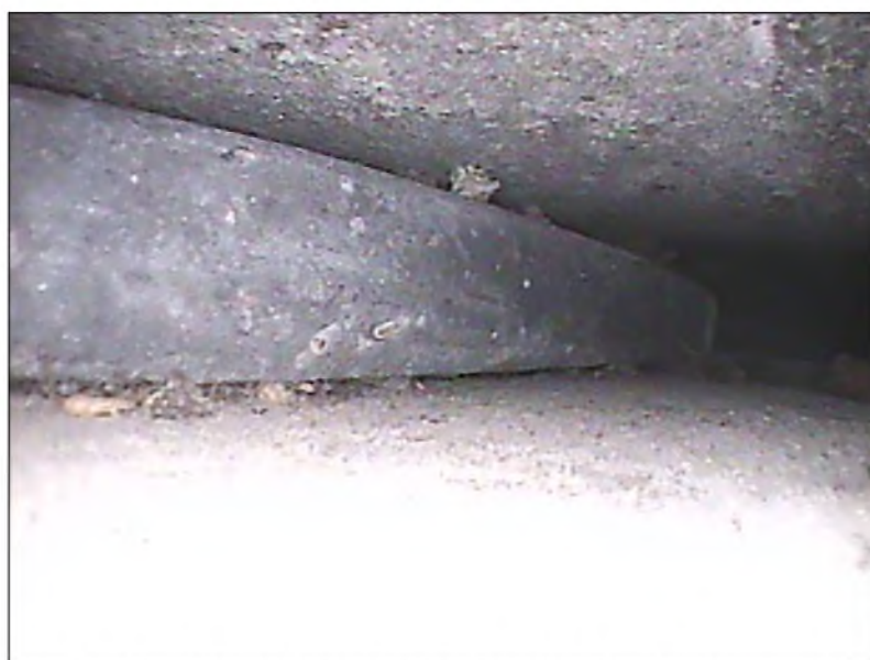
Obr. 11: Olověná deska v kloubu klenby; bez zjevného poškození
